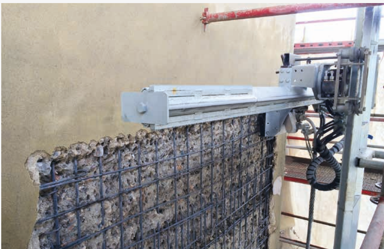
Boekentoren Gent tot 55 m hoog vanop een stelling – 6 cm diepte
