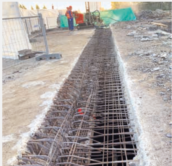
Wegspuiten voeg tot 70 cm diepte - werf Aalst.
