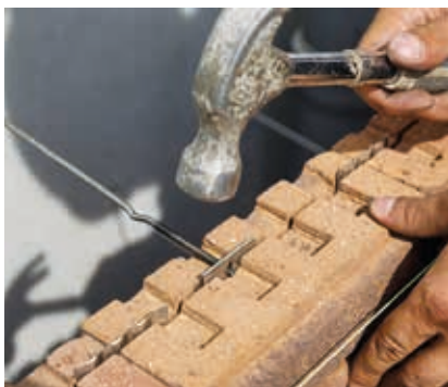
ClickBrick Pure – spouwankers zorgen voor verandering van gevel aan binnenspuwblad.
