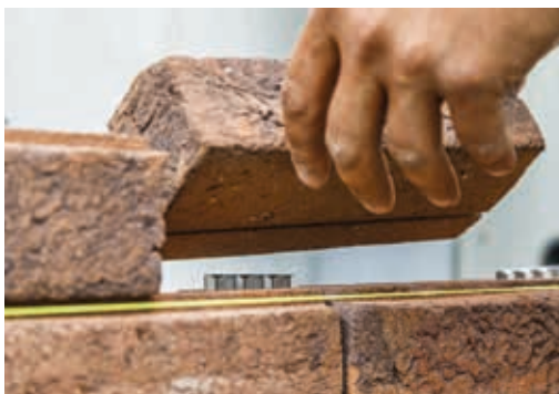
ClickBrick Pure – een droogstapelsysteem.
