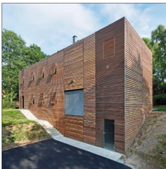
L'ensemble des menuiseries, tant extérieures qu'intérieures, est en afzélia et s'intègre dans la continuité du bardage. Le bardage a permis l'application d'une isolation renforcée sur la totalité des façades. Le bois est l'élément principal du projet, utilisé tant en extérieur qu'en intérieur: menuiseries intérieures, mobiliers, parquets déclinent le bois sous toute une série de formes différentes.
