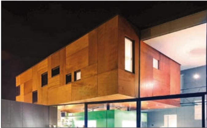
Le bois est destiné au « volume de nuit » qui jouit d'une isolation performante en cellulose. La dalle de béton lissée forme le plateau du rez-de-chaussée et augmente l'inertie thermique du bâtiment. Elle inclut le chauffage sol alimenté par une pompe à chaleur air/eau. Les murs de fermeture sont réalisés en blocs de béton cellulaire (ép. 36 cm), matériau employé pour son bon rapport inertie-isolation.
