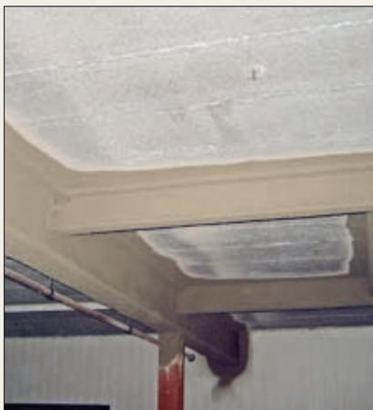
Le Cafco MANDOLITE® CP2 est un mortier projeté modifié à base de ciment et de vermiculite pour la protection contre l'incendie de colonnes et de poutres en béton ou en acier, des toitures en acier, des sols en béton, etc. Le Cafco MANDOLITE® CP2 peut être appliqué à l'intérieur ou à l'extérieur à l'abri.
