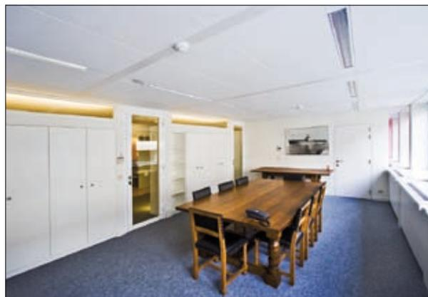
(en remplacement de la lourde couche de plâtre ou d'aluminium renforcé). Ils restent ainsi légers et faciles à découper. Cette composition unique allie une haute absorption acoustique (0,85 à 0,90 aw) et une isolation longitudinale de respectivement 35 et 40 dB en un seul panneau pour plafond.
