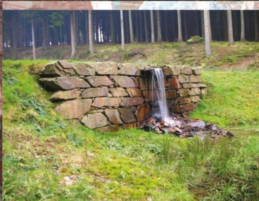
Le grès schisteux de la Warche (pierre Nelles) possède les avantages du grès -non gélif, forte densité portante, résistance à l'usure- tout en possédant les qualités des schistes, pierres structurées permettant une taille naturelle. Ces qualités en font une pierre de maçonnerie façonnable, dans le respect de sa structure, sa nature "sauvage", son caractère.
