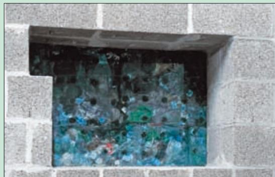
Vue éclatée dans un mur de cave, montrant le drainage réalisé en blocs de bouteilles plastiques comprimées; mur en blocs de béton réalisés à partir de sable de scories issu de la fabrication de métaux non-ferreux.
