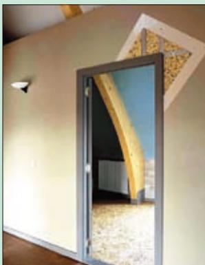
Une cloison de l'étage : à l'avant-plan, panneaux à base de sulfogypse et de phosphogypse avec isolation en mousse de polyéthylène recyclée, sol en panneaux de déchets de bois, cloison du fond en panneaux de gypse avec papier recyclé.
