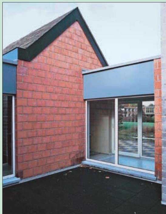
Vue du patio entre les annexes et le bâtiment principal : sol en dalles drainantes de caoutchouc recyclé, murs en blocs de terre cuite avec déchets de polystyrène expansé, planches de rive en laine de roche recyclée et comprimée, couverture en déchets plastiques ménagers recyclés.
