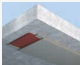
Bescherming met plaatmateriaal
