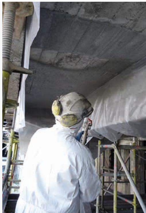
Het aanbrengen van een carbonatatie-remmende coating.
