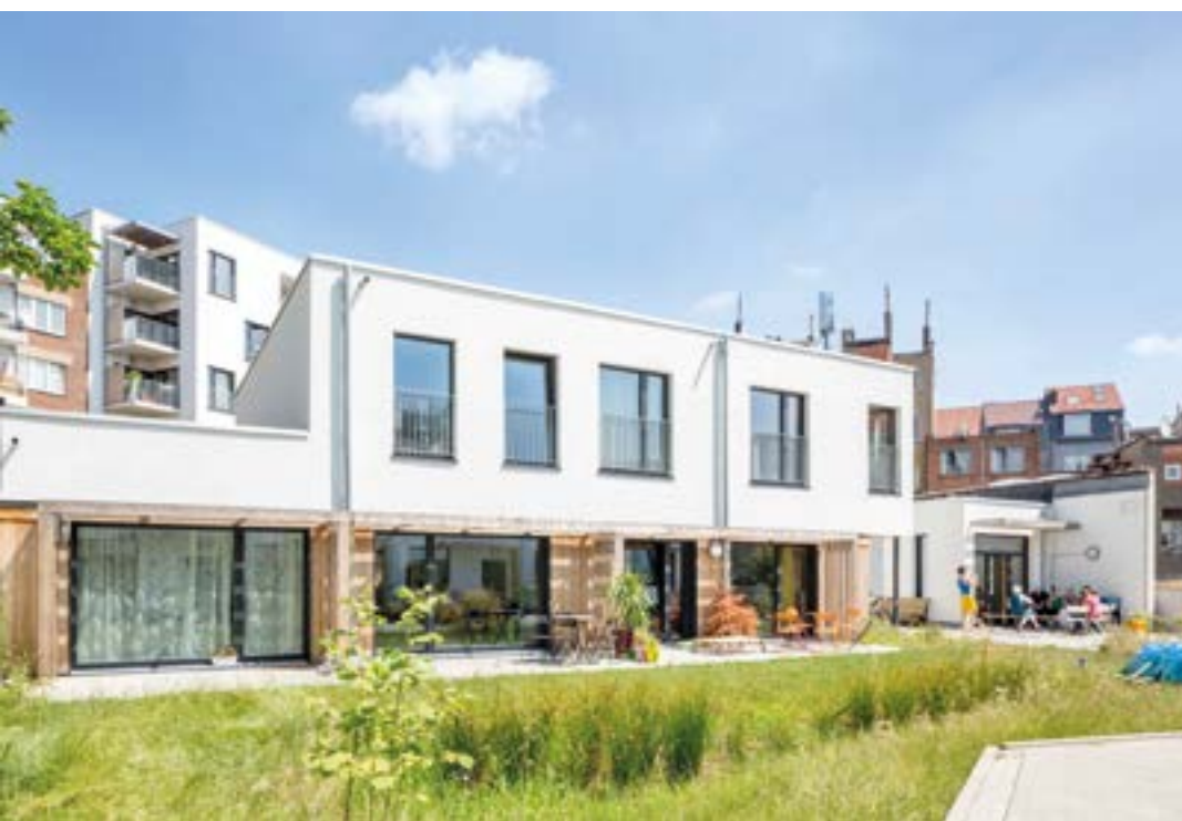
Complex met negentien woningen en een kinderopvang in Brussel – arch. Atlante – Écorce, Bouwschil, engineering & consultancy – www.damienfranzen.be – © Foto Lode Saidane Lage milieu-impact, dens wonen en sociaal bewustzijn in een stedelijk kader.
