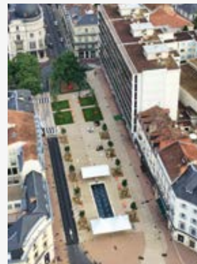
Luchtfoto van een fraaie publieke ruimte in het Franse Périgueux.
