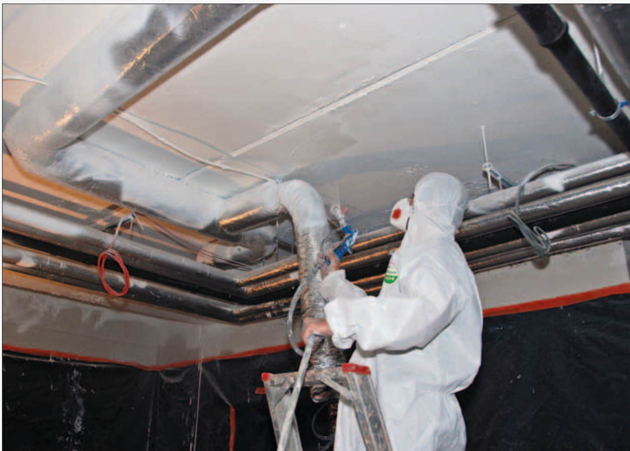
Brandwerende bescherming voor 120 min. van de betonnen vloer met PROMAPAIN-SC3
