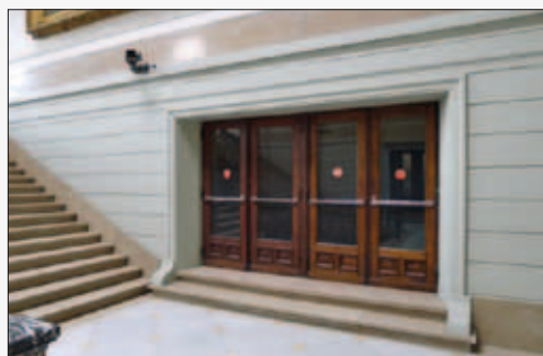
Brandbescherming van de historische deurpanelen — Koninklijk Museum Centraal Afrika in Tervuren.
